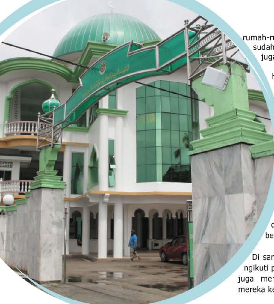
Bangunan masjid Pondok Terusan setinggi tiga tingkat
